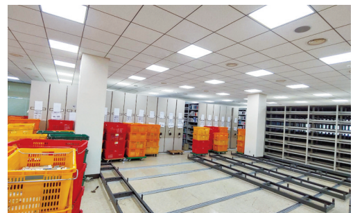
모빌랙 서가 설치
