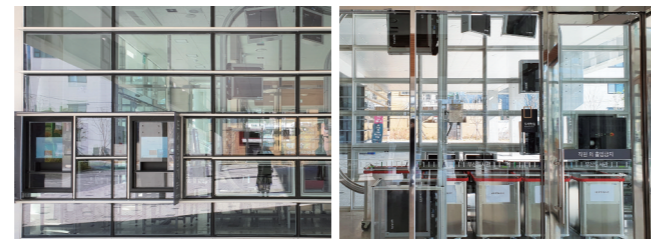
건물 외벽에 위치한 <무인반납기>
